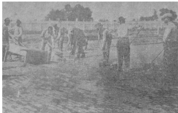
图 1.5 铺砖路面缝隙中灌注水泥浆
