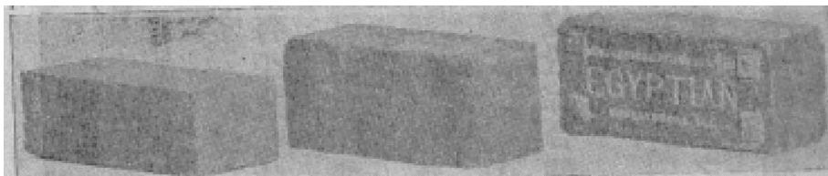
图 1.4 国外 20 世纪初铺筑路面使用的方砖
