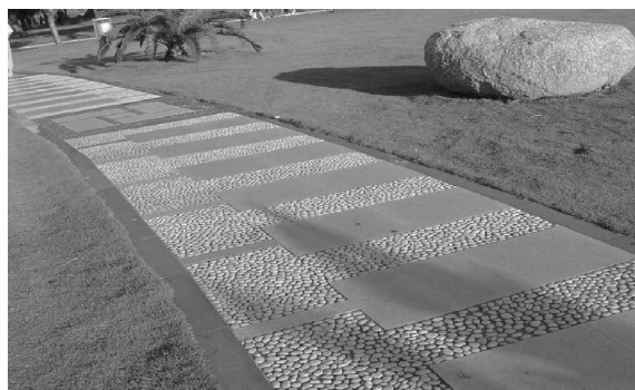
图 1.7 景区公路块料路面
