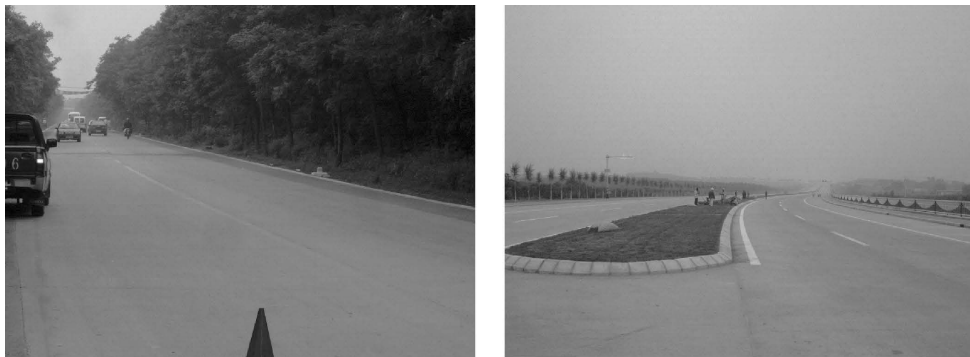
图 1.9 公路水泥混凝土路面
