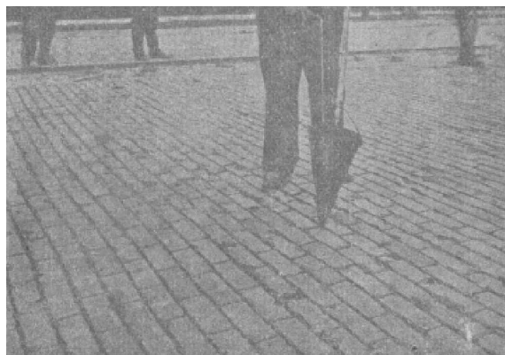
图 1.6 铺砖路面缝隙中灌注热沥青
