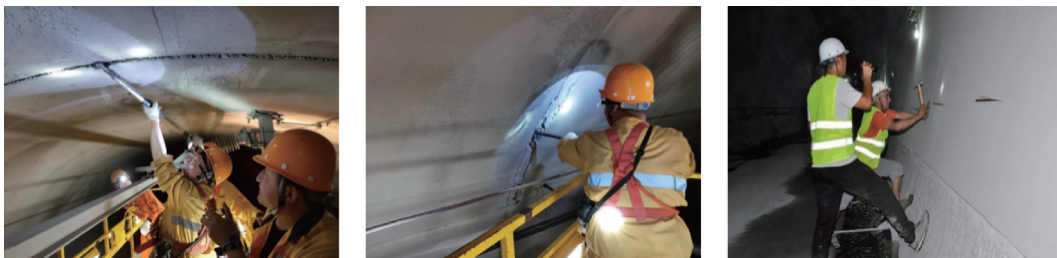
图 1.2.2-1 以人工巡检为主的隧道检测
