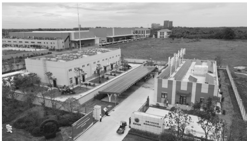
图 1-2 我国首座兆瓦级氢能综合利用示范站（安徽六安）
